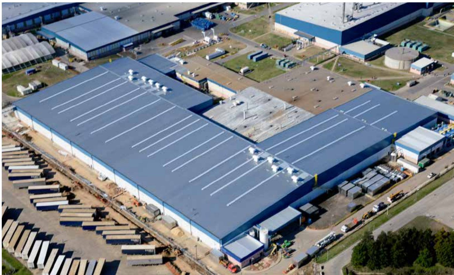
PLANTAS AUTOMOTRICES. NUEVO EDIFICIO DE MOTORES.
